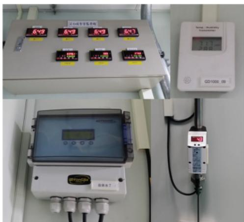
圖 4. 各感測器安裝完成圖，監控箱 (左上)，自來水／純水流量表 (左下)，溫溼度顯示 (右上)，壓縮空氣流量計 (右下)。
